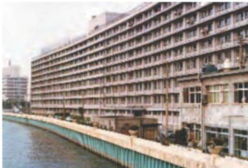
堂島川の田養橋付近から見た、昔の阪大病院
